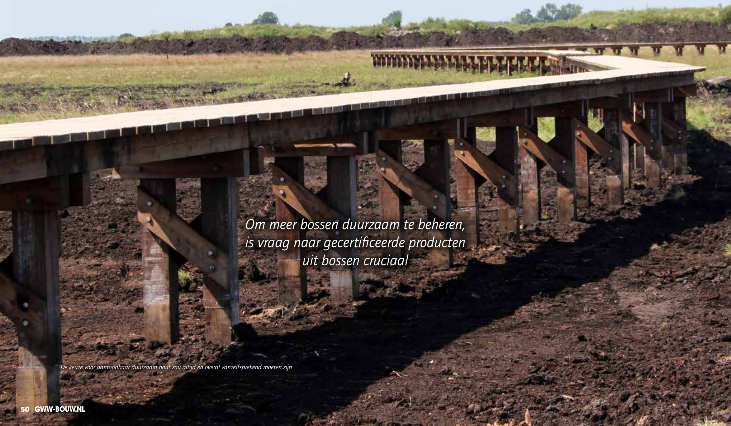
De loopbrug is gemaakt van samengestelde palen.
