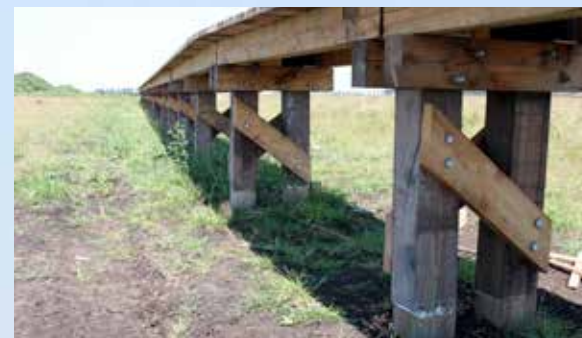
De loopbrug is gemaakt van samengestelde palen.
